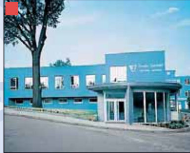
JUNKER Grinding Technology Чтиржколи, Чешская Республика
